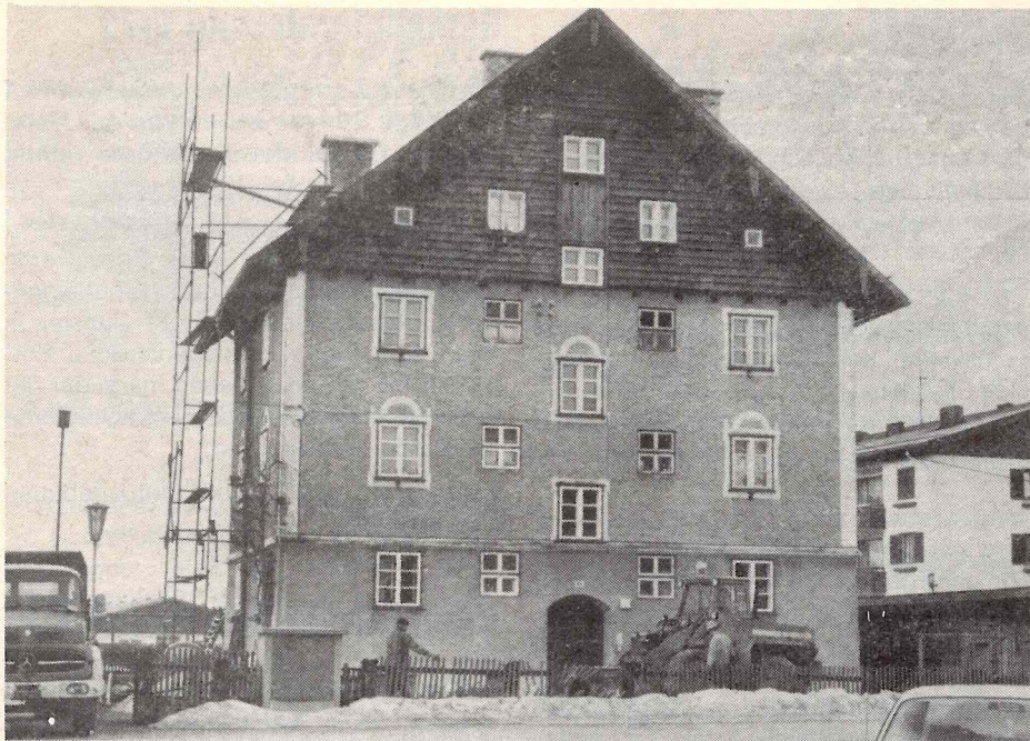
Das Gemeindewohnhaus während der Sanierungsarbeiten.
