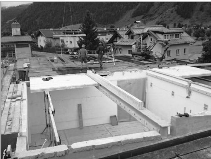
Das alte Dach wurde bereits entfernt und die neue Geschoßdecke aus KLH-Holzplatten wird verlegt. Das Bild zeigt den Bewegungsraum im jetzigen 1. Obergeschoß.
