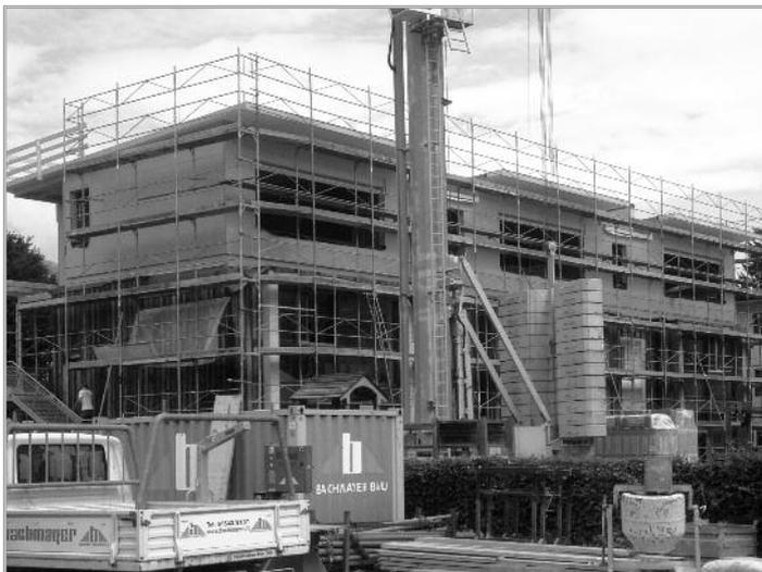
Ein Bild mitten in der Bauphase. Das 2. Obergeschoß ist bereits fertig montiert, links und rechts sind die beiden neuen Gruppenräume, in der Mitte der zugehörige Bewegungsraum.
