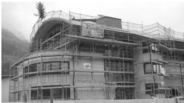
Die Bauarbeiten sind bereits sehr weit vorangeschritten. Fenster, Stiegenhausportal sowie Teile der Holzfassade wurden bereits montiert.
