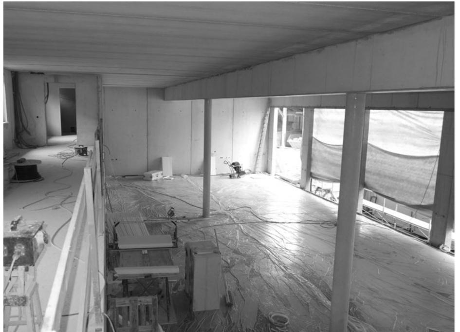
Ein Blick in die neue Fahrzeughalle der FFW Maishofen. Der Estrich wurde hier bereits eingebracht. In der neuen Fahrzeughalle werden in Zukunft insgesamt 5 Fahrzeuge Platz finden. Neben der Unterbringung der Fahrzeuge wird es für den Bereich der Feuerwehr auch noch weitere Räumlichkeiten geben: Kommandoraum, Werkstätte, Umkleide- und Sanitäreinrichtungen, Atemschutzraum, Kompressorraum, eine Stiefelwaschanlage, ein Bereitschaftsraum sowie ein Raum für die Feuerwehrjugend.
