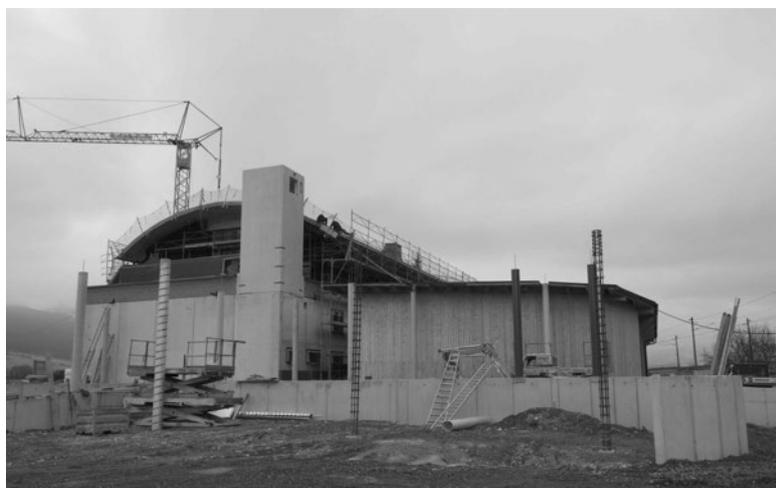
Im Bild gut zu sehen der Schlauchturm. Hier auf der Südseite des Gebäudes wird auch eine Photovoltaikanlage montiert werden. Im Vordergrund bereits erkennbar der Bereich der neuen Altstoffsorgung. In Zukunft wird man über eine Rampe auf Containerhöhe anfahren können und muss nicht mehr die Altstoffe über Kopf entsorgen sondern kann diese von oben in die Container werfen. Auf den Betonsäulen wird die Überdachung für diesen Bereich aufgesetzt werden.
