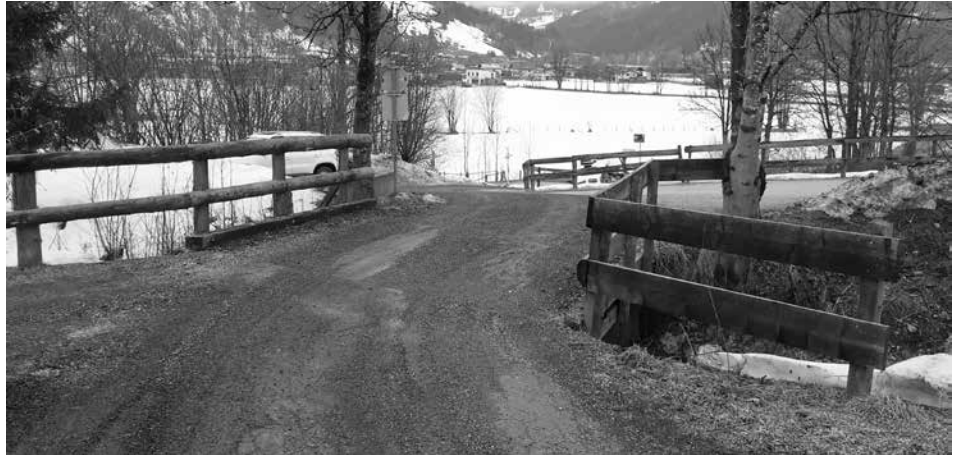
Im Bild: die Lohwegbrücke vor der Sanierung
