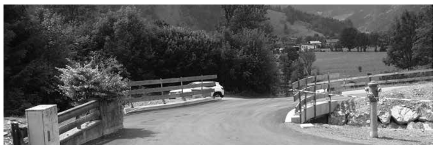
Im Bild re.: die neue Loh- weg- brücke
