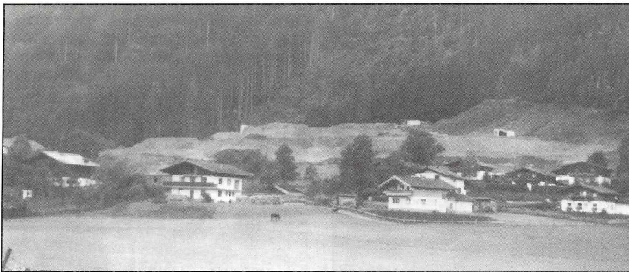
90.000 m 3 Tunnelmaterial des Stichtunnels sollen in Oberreith gelagert und anplaniert werden. Die Wildbachverbauung wird dann nicht mehr sichtbar sein. Staub- und Lärmbelastung sind zeitweise unerträglich.
