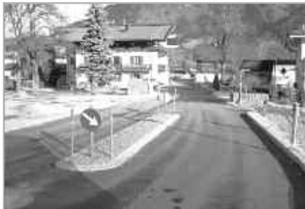
Sanierung der Straße durch Unterreit: Bis auf die Asphaltfeinschicht konnte aufgrund der guten Witterung die Durchfahrt fertig gestellt werden.
